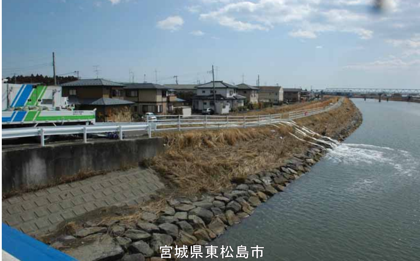
0304_2_018_010700_東松島市(広報)_2011.3.19_赤井地区_排水作業
