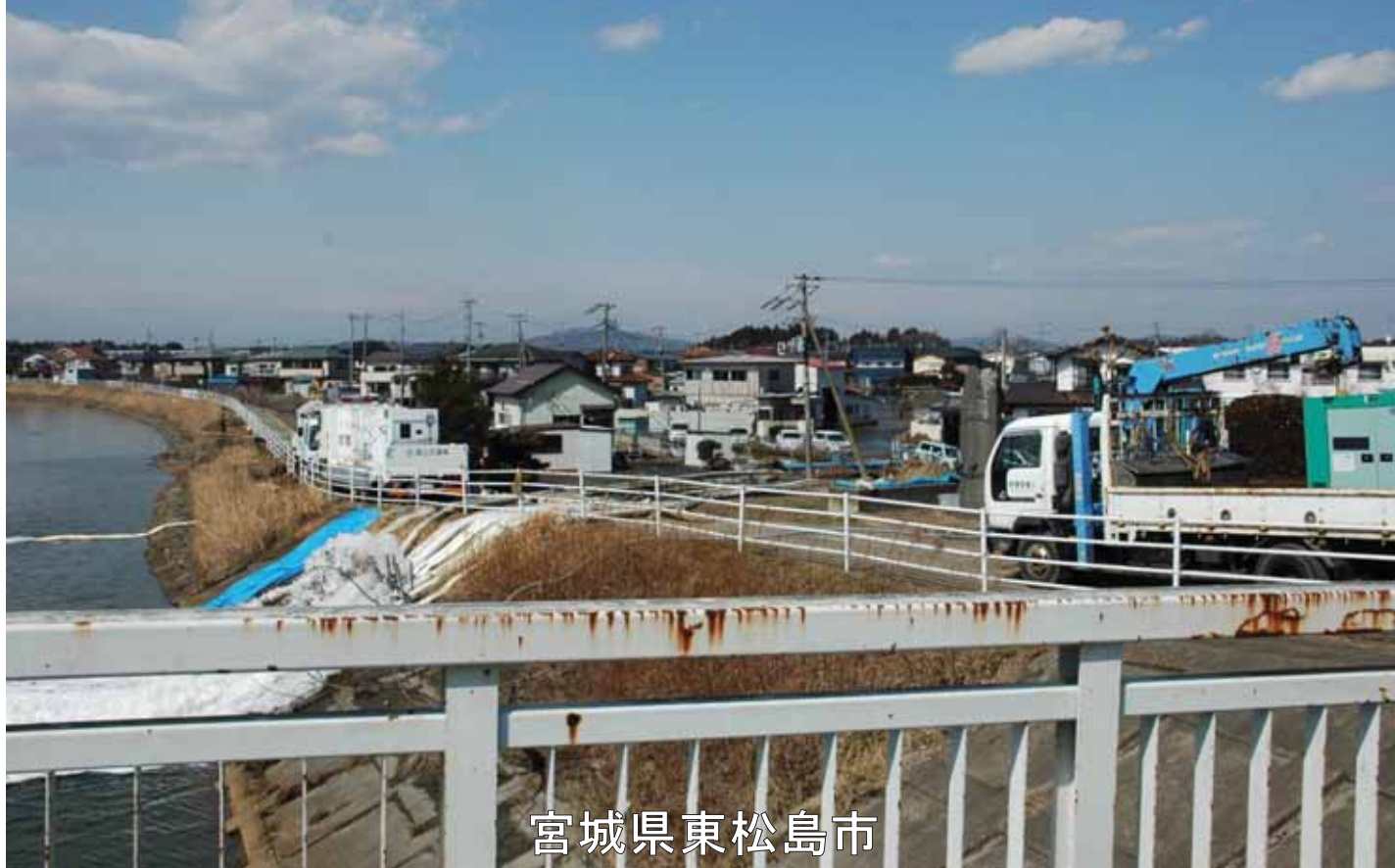
0304_2_018_010695_東松島市(広報)_2011.3.19_赤井地区_排水作業
